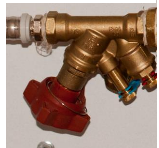
Bild 7. STAD-ventil på utloppsriör
