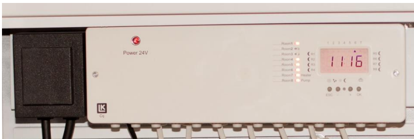
Bild 2. Släckta dioder på slingorna 2 och 3
